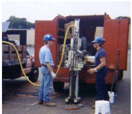
Geo-probeを用いたHRCの注入風景
